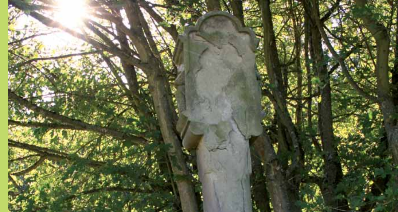
Verwitterter Bildstock mit vierseitigem Aufsatz Poppenhausen 1621, Inv. Nr. 0264 Starke Verwitterung hat die Schauseite dieses Bildstocks abplatzen lassen.
